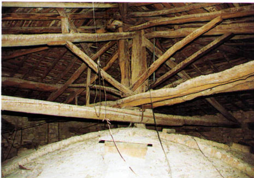
Sottotetto: le grandi capriate di castagno da recuperare e restaurare
