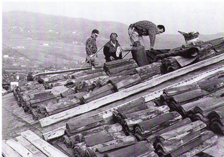
Il tetto: ricollocazione in opera del manto di copertura in tegole curve
